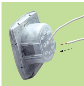
Insertar los cables en los agujeros correspondientes por la parte trasera del protector y conectarlos al mecanismo
